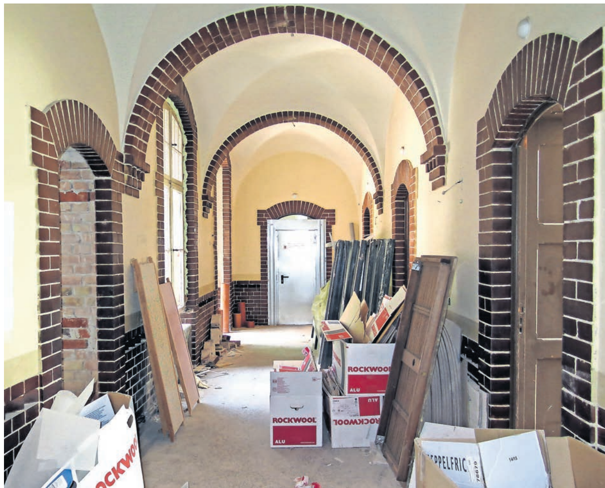
Die Gewölbe und Bögen sind typisch für das denkmalgeschützte Gebäude.
