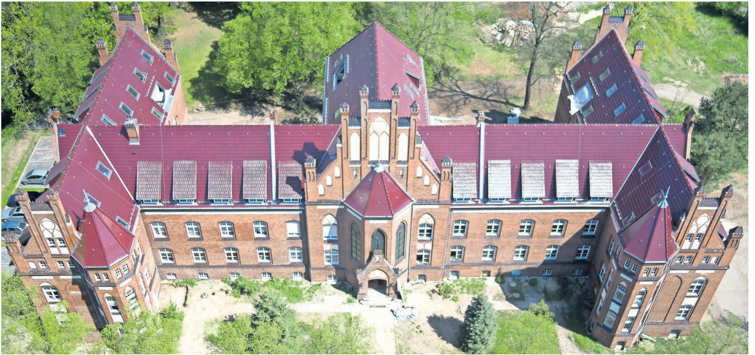
Das sanierte Luckenwalder Heinrich-Stift in der Lindenstraße aus der Vogelperspektive. Das Dach wurde komplett erneuert, die Fassade aufwendig restauriert.
